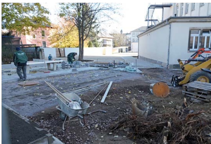
Schritt für Schritt gehen die Bauarbeiten voran. Die Fläche für die Fahrradständer ist bereits gepflastert und die erste Tischtennisplatte steht.
