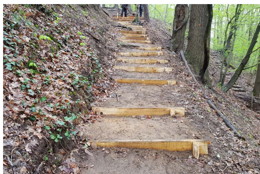
Sicherung Wege mit Holzstufen
