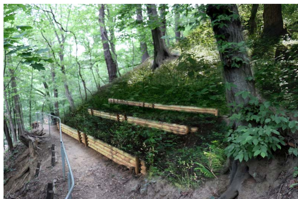
Hangsicherung mit Holzstämmen
