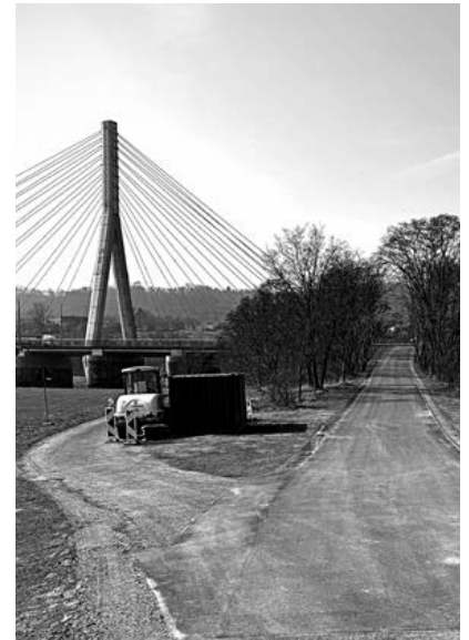
Neue Fahrradrampe zur Elbquerung an der Brücke Niederwartha
