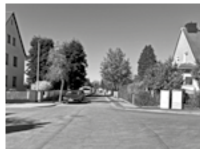
Sachsenstraße/ Fichtestraße nach Fertigstellung (Blickrichtung Westen)
