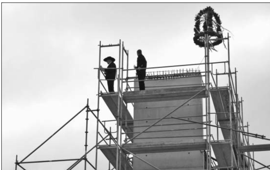
Am 23. Oktober 2007 fand das Richtfest für das Rettungszentrum (Bauteil Feuerwehr) auf der Wilhelm-Eichler-Straße 36 statt. Im Mai 2008 sollen dann die Kameraden der Freiwilligen Feuerwehr ihr neues Quartier, mit Schulungsräumen, separaten Umkleeräumen, Duschen, Toiletten und Stellplatz für sieben Fahrzeuge beziehen können.
