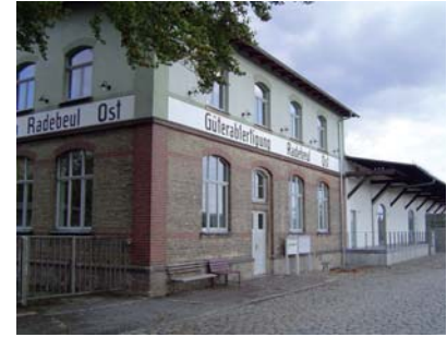
Ehemaliges Verwaltungs- u. Lagergebäude
