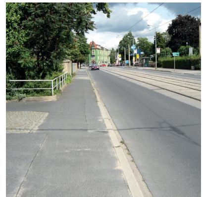
Sanierungsabschnitt Meißner Straße (Beispiel)
