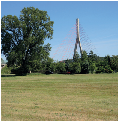
Niederwarthaer Brücke als neue Verbindung zur Autobahn in Dresden
