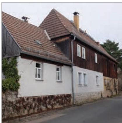
Gaubenloses Walmdach des Winzerhauses Winzerstraße 22/24
