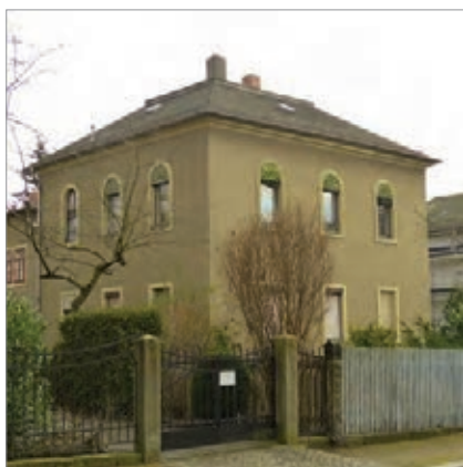
Würfelförmiger Baukörper der Dr.-Schmincke-Allee 24
