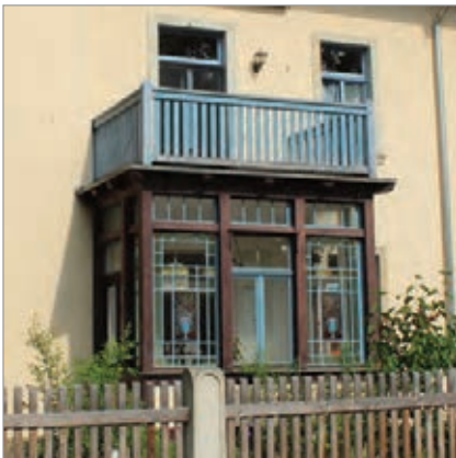
Hölzerne Veranda mit Austritt im Obergeschoss, Schweizerstraße 5
