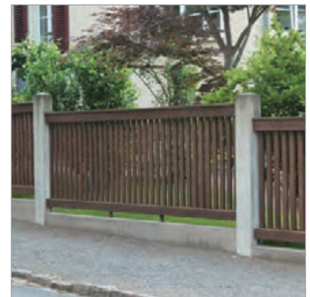
Zaun der 1920er Jahre mit oberem und unterem Brett, Nizzastraße 24
