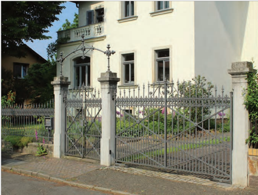
Aufwändig gestalteter schmiedeeiserner Zaun der Schweizer Straße 13, das Tor höher als das Zaunfeld
