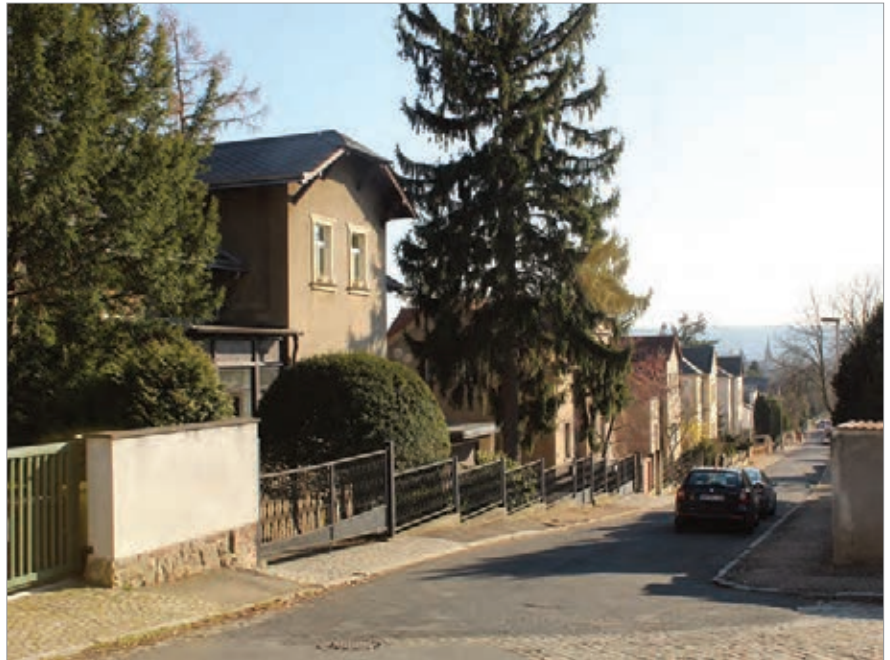
Homogene Bauflucht der Hauptgebäude am Gradsteig 42 bis 56
