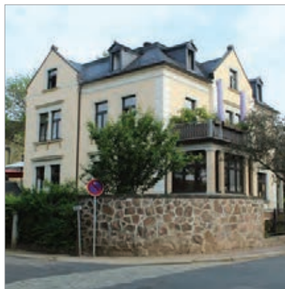
gebogene Bruchsteinmauer an der Straßenecke Rosenstraße 9
