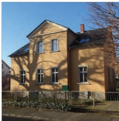
Fassade gleicher Gliederung Ledenweg 23, Dekor wahrscheinlich entfernt
