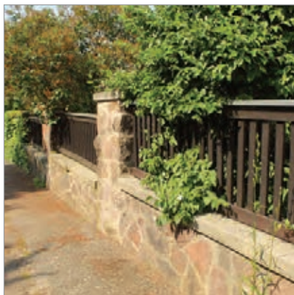
Holzzaun, Bruchstein-Pfosten und Sockel an der Gröbastraße
