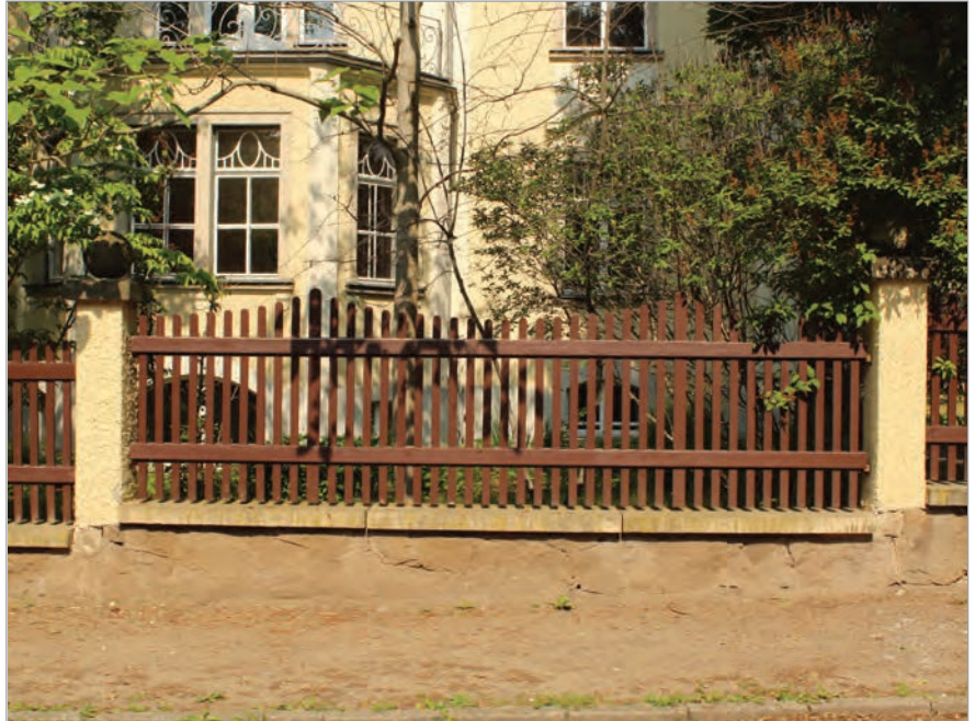
Zaunfelder aus Holz zwischen massiven Pfosten frieden die Villa Dr.-Külz-Straße 25 ein. Der Bruchsteinsockel ist mit Platten abgedeckt.
