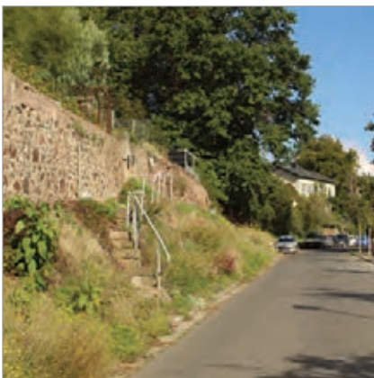
Gebäudezugänge über begrüneten steilen Hang an der Oberen Bergstraße
