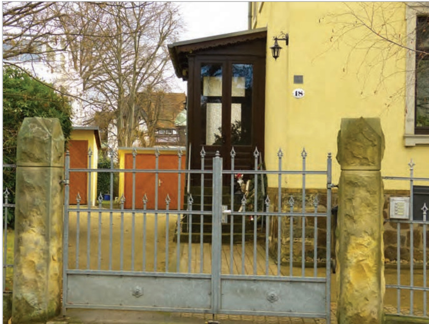
Anordnung der Garagen der Dr.-Schmincke-Allee 18 hinter dem Hauptgebäude, Zugang gepflastert, Zufahrt nur wassergebunden befestigt
