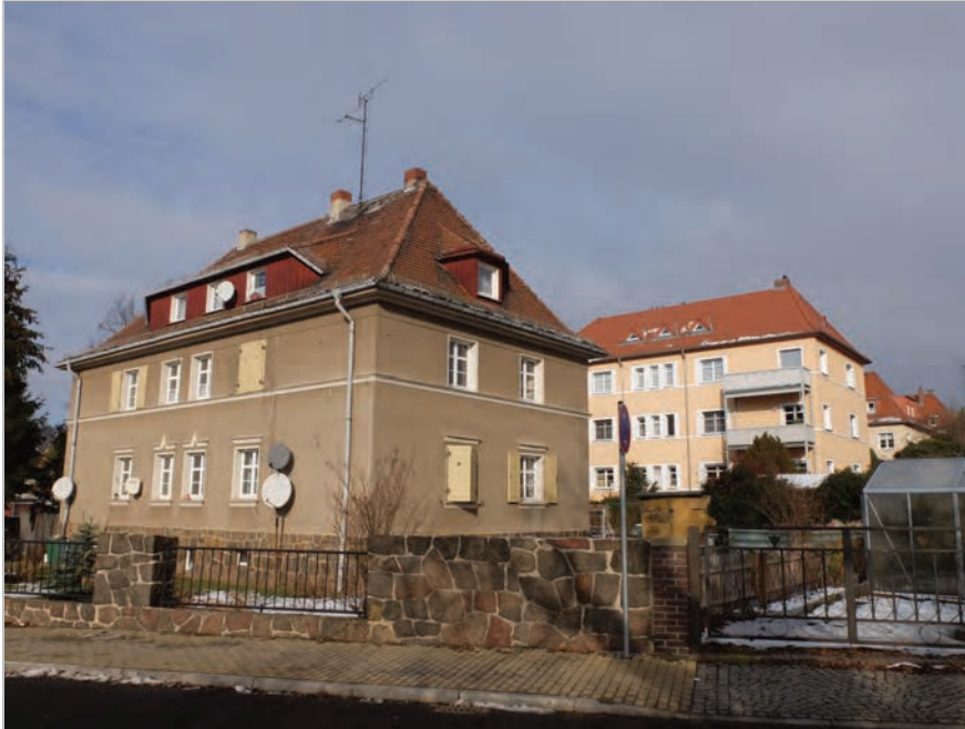
Wohnhäuser Heinrich-Zille-Straße 20 und 22 der Baugenossenschaft Kötzschenbroda, errichtet in den Jahren 1929 und 1931
