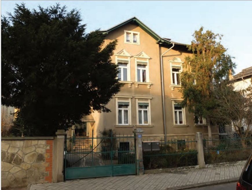
Dreigliederung des Baukörpers in Sockel (Bruchsteinmauerwerk), aufgehende Fassade und Dach an der Goethestraße 10
