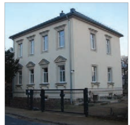
Schlichtes, flach geneigtes Walmdach der Käthe-Kollwitz-Straße 11
