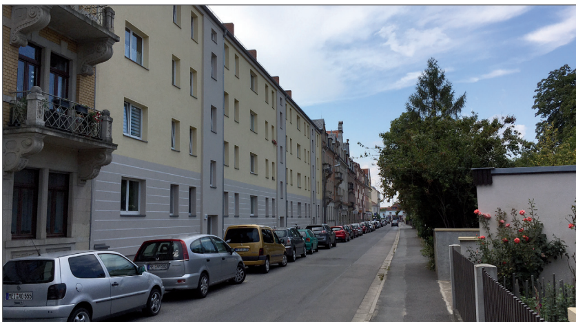
Hermann-Ilgen-Straße, südliche Bebauung
