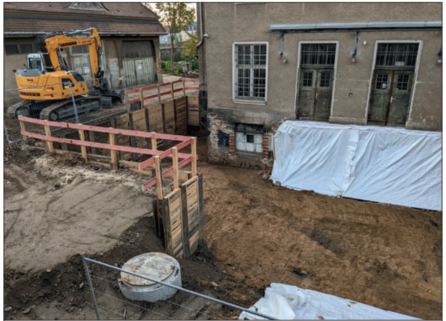
Verbau und Aushub für den Neubauteil an der Musikschule
